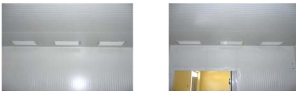
Şekil 2. Emme ve üfleme menfezlerinin genel görünümü
