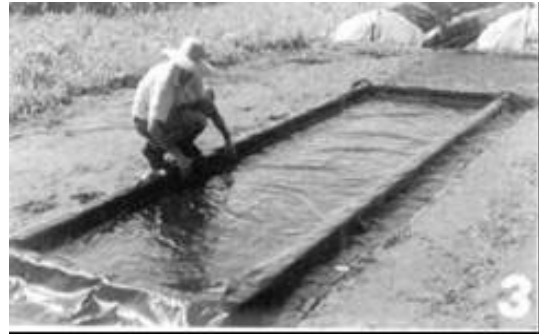
Şekil 3.3. Havuz içine siyah naylon serilmesi
