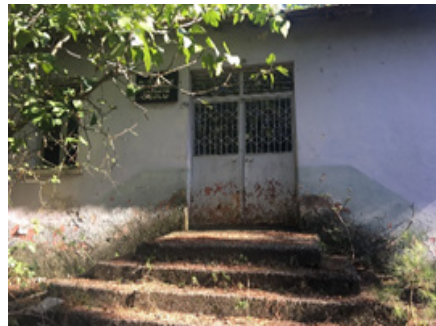
Resim 17: Okulun Giriş Kapısı
