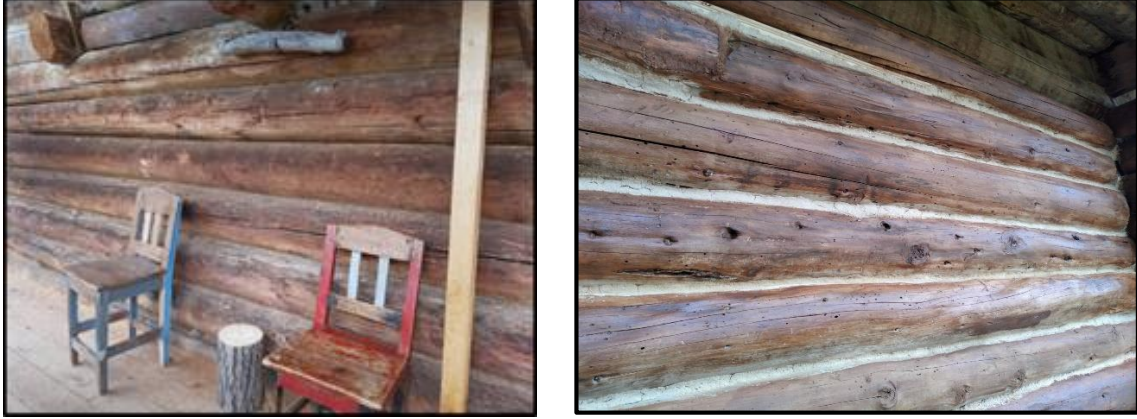
Fotoğraf 13-14: Evin salona dönüştürülen birinci katın ön cephesi.
