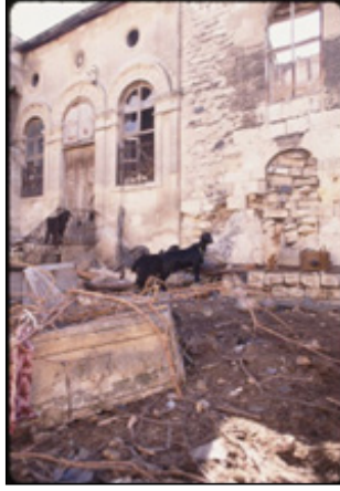
Ek 13. Kilis Sinagogu, Restorasyon Öncesi, Kuzey Batıdan Güney Cephesine Bakış ( https://www.omnia.ie/ )
