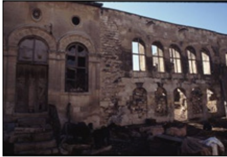
Ek 14. Kilis Sinagogu, Restorasyon Öncesi, Güney Cephesi ( https://www.omnia.ie/ )
