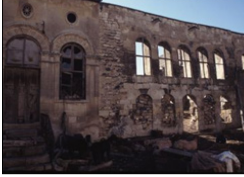
Ek 4. Kilis Sinagogu, Restorasyon Öncesi Güney Cephe ( https://www.omnia.ie/ )
