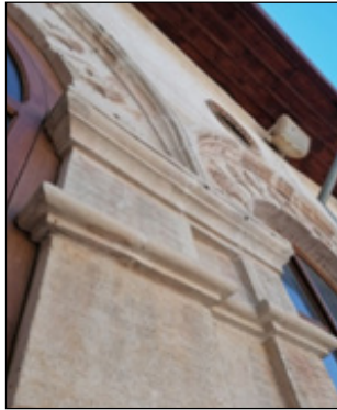
Ek 18. Kilis Sinagogu, Restorasyon Sonrası, Güney Cephedeki Kemer Binneleri ve Silmeler
