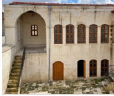
Ek 23. Kilis Sinagogu, Restorasyon Sonrası, Dođu Cephesi
