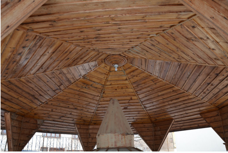
Şekil 21. Alaca Mescit Camii Şadırvanı Örtü Sistemi İç Görünüm
