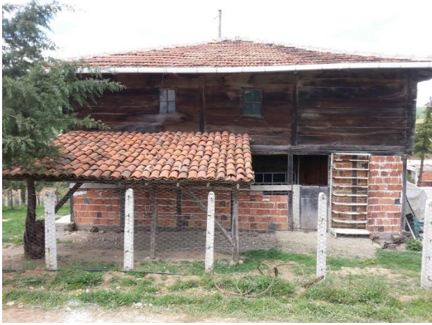
Resim 8: Alagömlük Köyü Rahmioğlu Mahallesi Camii'nin Doğu Cephesi.
