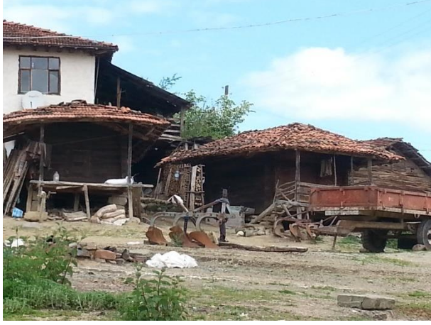
Resim 13: Alağömlük Köyü'ndeki Çanti Tekniğinde İnşa Edilmiş Ambarlar.
