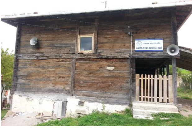
Resim 7: Alagömlük Köyü Rahmioğlu Mahallesi Camii'nin Güney Cephesi.
