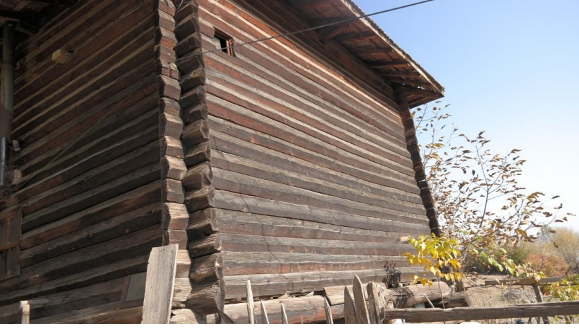
Resim 10: Çorakdere Köyü Corukdere Mahallesi Camii'nin Güney Cephesi.
