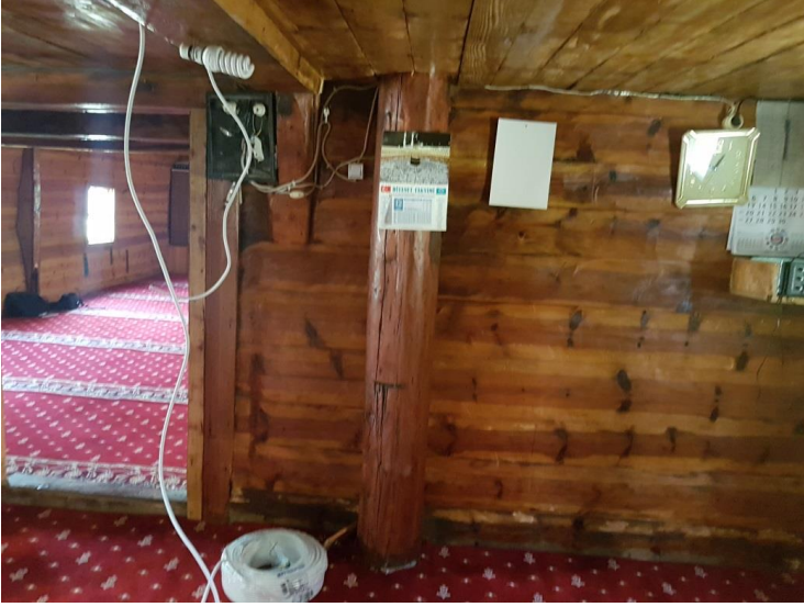
Resim 12: Çorakdere Köyü Corukdere Mahallesi Camii Minaresinin Mili.
