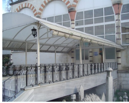
Resim 2. Merdiven ve son cemaat mahalli
